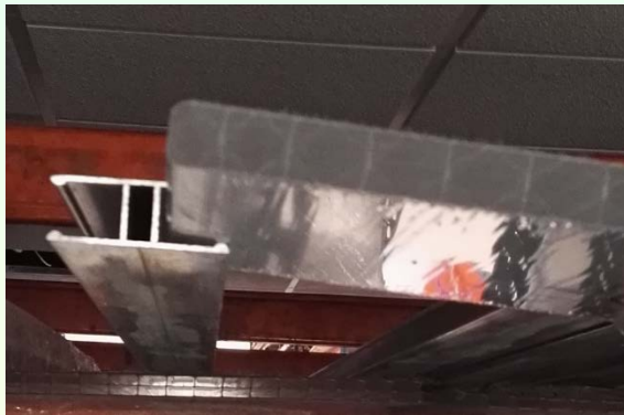
Foto 6: PC celular sujetado en perfil H de aluminio, ejemplo de unión y terminación de perfil en H
