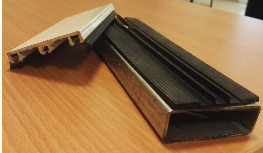
Foto 4: Detalle del perfil inferior con su goma plana instalada y del perfil superior con sus juntas trapezoidales.
