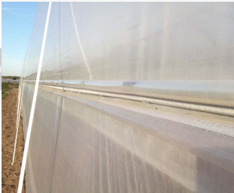
Perfil omega con tuvo de polietileno para fijación de plástico.
