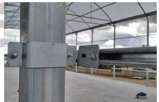
(Izq) detalle de sujeción de malla con perfil H. (drcha) perfil H con sus distintos componentes y detalle de agarre a la viga o columna con brida.
