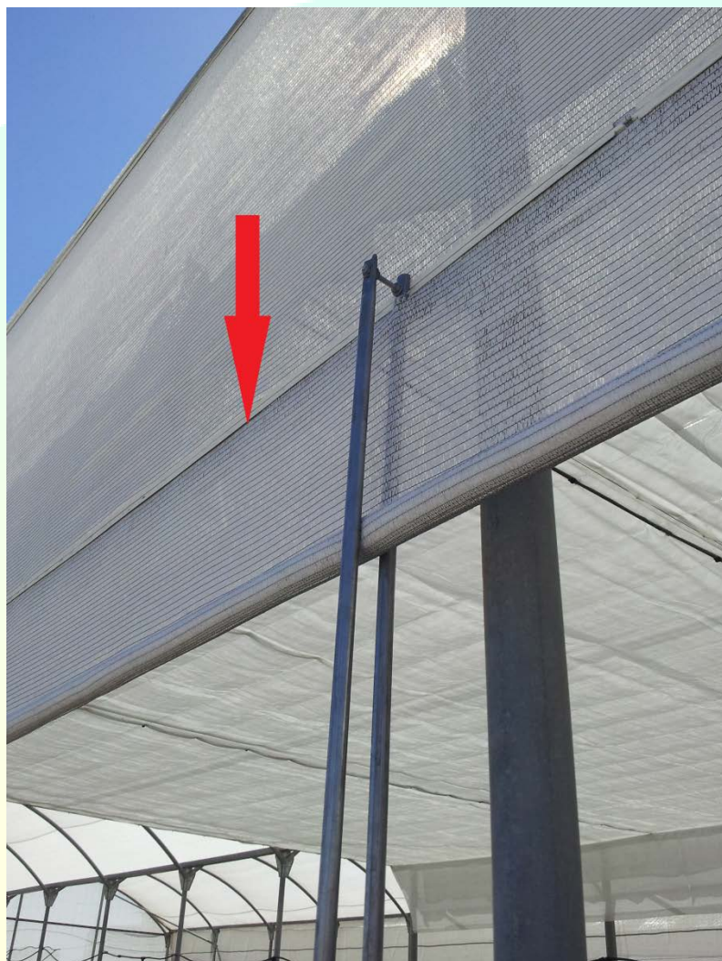
(Izq) detalle de sujeción de malla con perfil M. (drcha) perfil M con sus distintos componentes y detalle de agarre a la viga o columna con brida.
