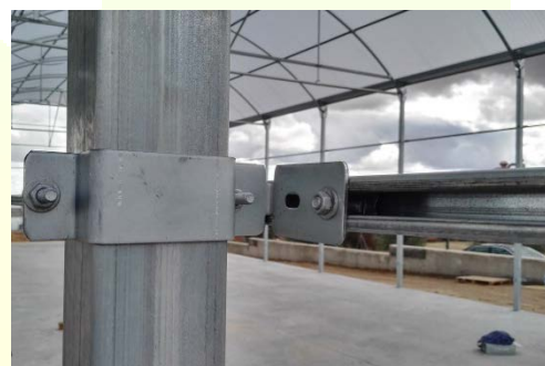
(Izq) detalle de sujeción de malla con perfil M. (drcha) perfil M con sus distintos componentes y detalle de agarre a la viga o columna con brida.
