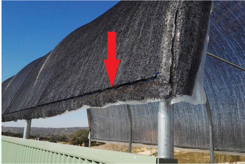
(izq)Detalle de sujeción de malla con perfil zig-zag, alambre con envoltura azul, (drcha) detalle del perfil con su alambre con funda transparente
