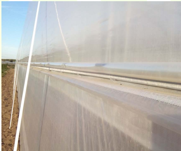
Perfil omega con tuvo de polietileno para agarre de plástico.
